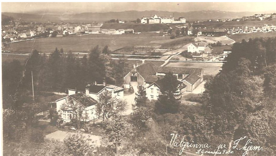
Figur 16 Bildet viser Paulinegård i forgrunnen, deretter Lund og Lerkendalgård bakenfor. Helt bakerst vises Gløshaugen med bebyggelse. Bildet er ikke tidfestet, men bildet antas å være fra første halvdel av 1900-tallet. Kilde: Wikipedia/ L. Granhus Foto (eget eie).
