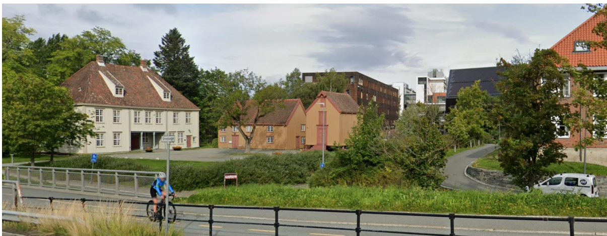
Figur 14 Lerkendal gård og SINTEF-bygget (t.h.) sett fra Strindvegen. Ny bebyggelse nord for jernbanelinja i bakkant.
