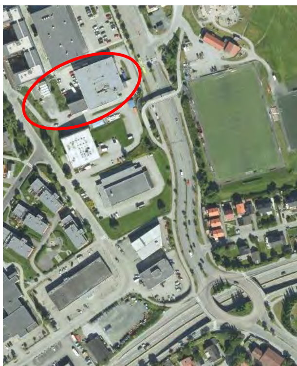
Figur 1-1 Planområdet er merket med rød sirkel. Det ligger idrettsbaner på motsatt side av Torbjørn Bratts veg og boliger opp mot Omkjøringsvegen.
