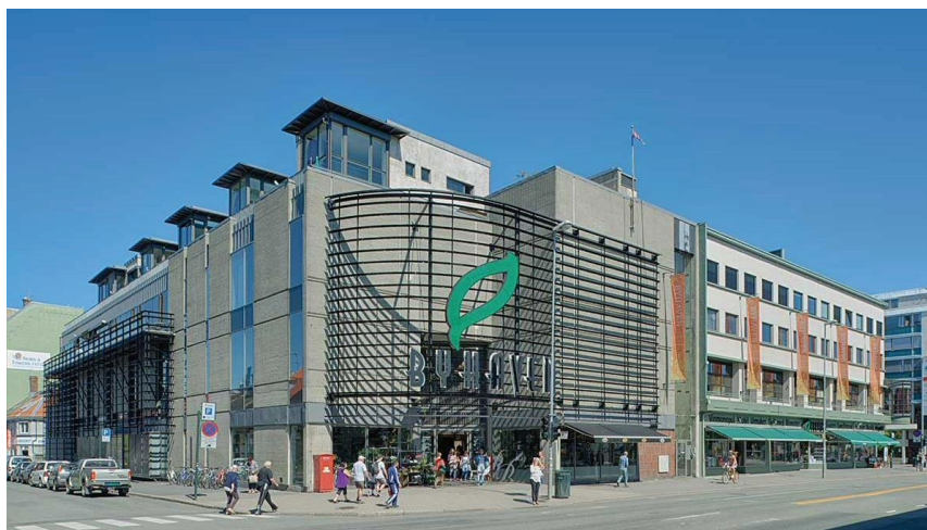
Byhaven, tidligere Lysholmgården og EPA. Ombygget med boliger på tak. Kilde: Skibnes Arkitekter.
