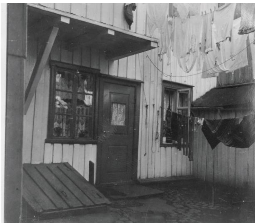
Gårdsrom i Willmannsveita 1934. Eksempel på trehusbebyggelsens gårdsrom, som gav rom for praktiske funksjoner som lufting og tørking av tepper og klær. Fra gårdsrommet fantes gjerne også atkomst til kjelleren, som gav en brannsikker oppbevaringsmulighet for særlige verdier. Kilde: John Platou/NTNU UB.
