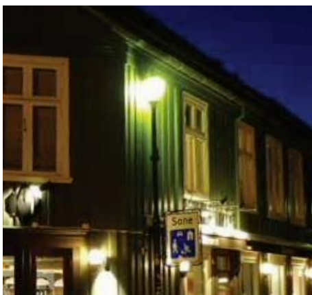
Uheldig plassering av Trolla armatur. Problematikk med strølys fra Trolla armatur ved plassering inntil bolig. Her er det behov for muligheten til å styre lyset bedre for å få bedre kontroll på hvor lyset treffer.
