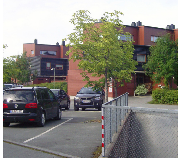
Inne på området er det en parkeringsplass og nedkjørsel til parkeringskjeller.
