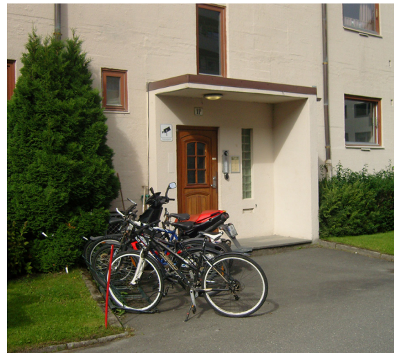
En oppgang med sykkelparkering til blokka i Udbygges gate. Denne ligger inntil fellesområdet.
