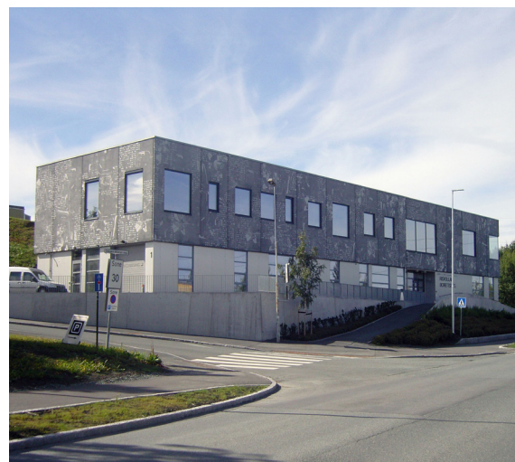
Borettslaget fikk i 2015 et administrasjonsbygg som inneholder kontorer, fellesskapsfunksjoner, drift- og verkstedsfasiliteter.
