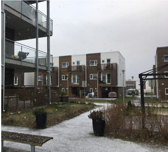
Boliger i første etasje har veranda på bakkeplan.
