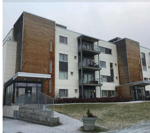
Inngangspartier på leilighetsbyggene ligger mot øst.
