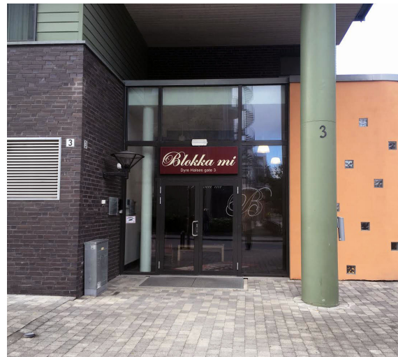
Inngangsparti til en av boligblokkene.
