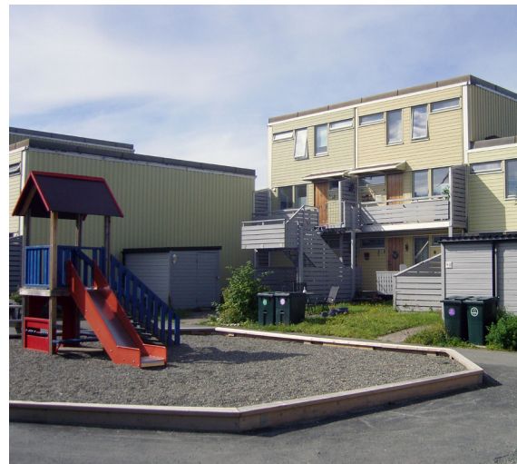
Mellom rekkehusene er det lekestativ, sitteplasser og beplantning.
