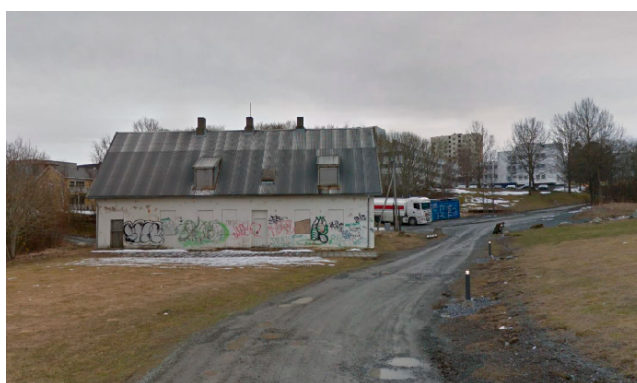
Verneverdig bygg sør for kaiområdet. Kilde: Rambøll
