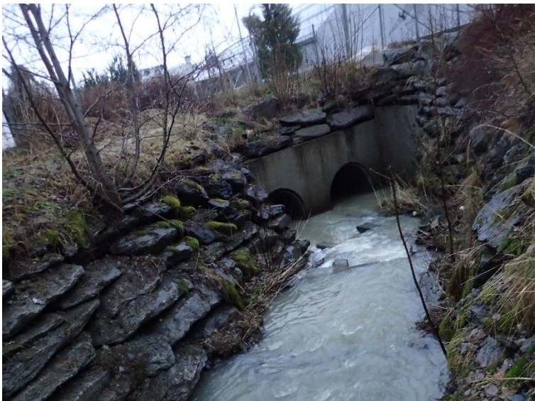
Figur 15 Kulvertene gjennom Ranheimsvegen sett fra oppstrøms.
