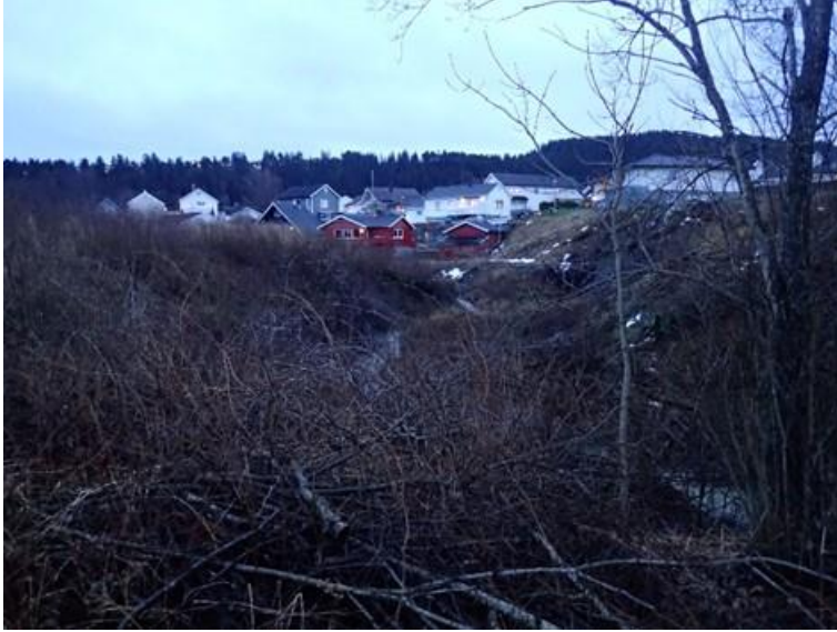
Figur 4 Sjøskogbekken går i øverste del av fokusområdet i en dal. På dette bildet ser man Sjøskogbekken fra nedstrøms og opp mot bebyggelsen i Martin Barstads veg. På befaring i desember 2021 ble observert mye erosjon på siden mot vest (høyre), og rør var gravd ut, knekt av og lå nå i vassdraget.
