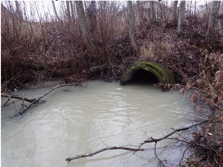
Figur 11 Utløpet av kulvert 3. Det er en kulp i forkant av røret, og nøyaktige innmålinger av hele denne er ikke målt inn.
