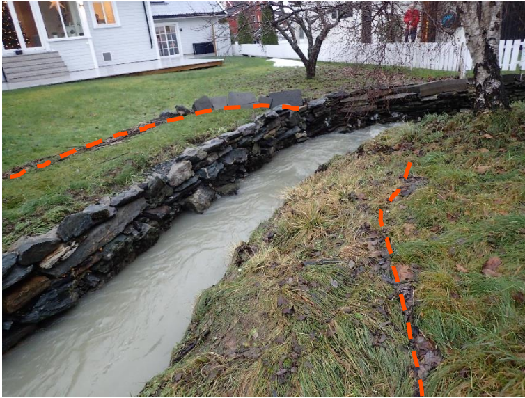
Figur 8 Sjøskogbekken går forbi eiendommene oppstrøms Prestmovegen i en smal kanal. På sidene er det markert hvor vannstanden stod før befaringen den 17.12.21.
