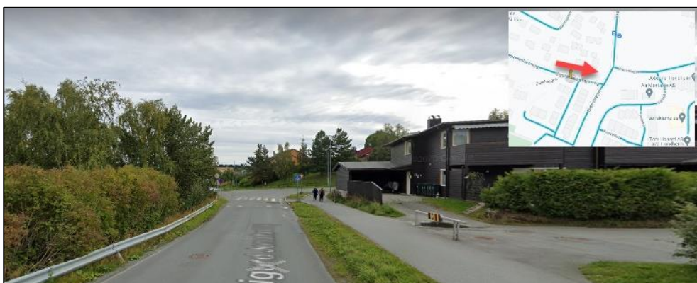
Figur 24: Sigurd Jorsalfars gate rett frem i bildet, inn mot krysset med Brøsetvegen. Bilde tatt i retning mot øst. (Google Maps)
