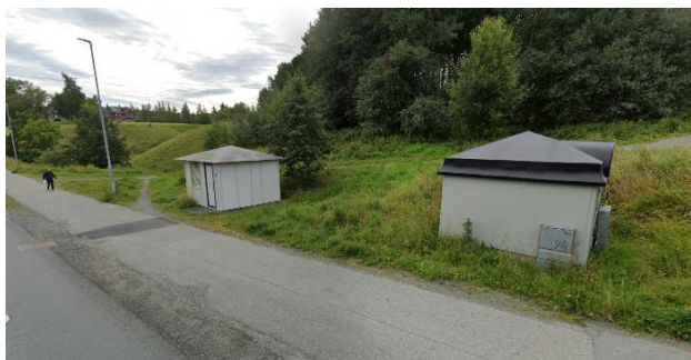
Figur 5: Eksisterende trafo og pumpestasjon (Google Maps)
