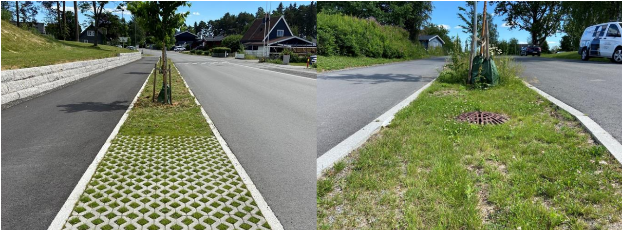
Figur 4: Eksempel på urban grøft hentet fra Norconsult sitt prosjekt i Hamar. Gressarmering i avkjørsel til privat bolig, 0-vis kantstein som lar vann renne ned fra både kjørefelt og gangareal. Sluk med jevne mellomrom.
