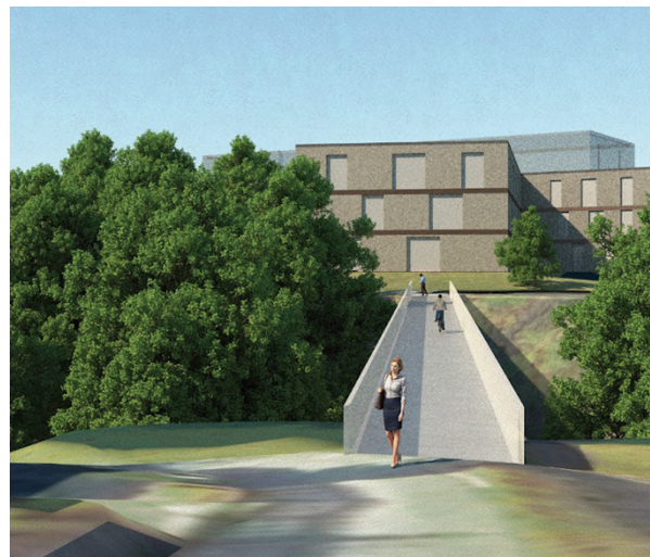
Ny bru sett fra konglevegen, med helse- og velferdssenter i bakgrunnen.
