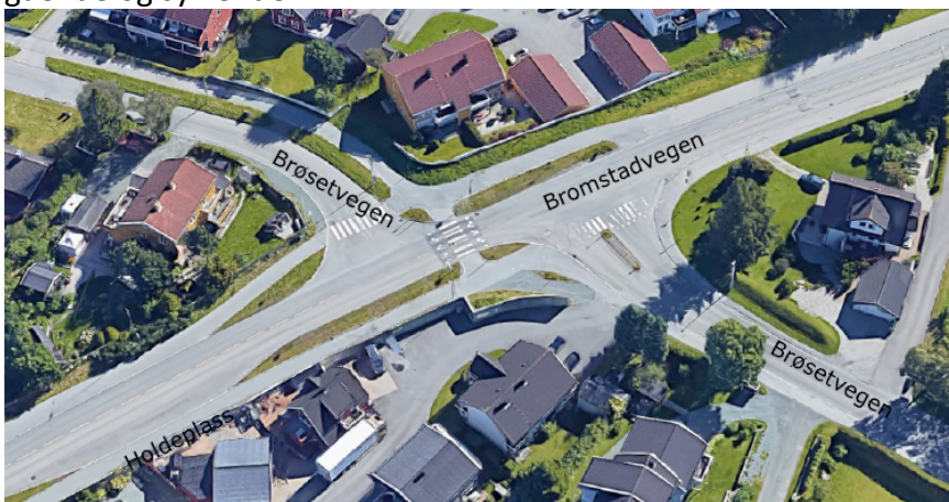
Krysset Bromstadvegen og Brøsetvegen
