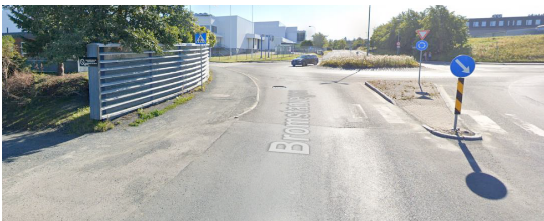
Fortauet ved rundkjøring i Tungasletta er utflytende/gruslagt og dette kan skape farlige situasjoner (skli på grusen)
