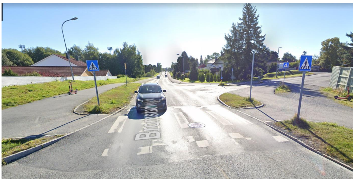
Figur 30: Kryss Bromstadvegen x Brøsetvegen i dag, utflytende område og systemskifte fra gang- og sykkelveg til fortau
