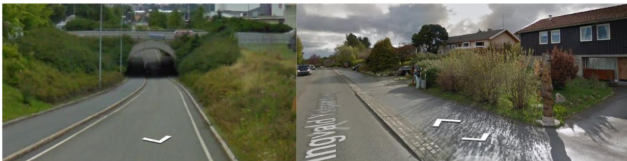
Figur 4: Bildet til venstre viser kulverten under Omkjøringsvegen ved Tunga, med et toveis kjørefelt og ensidig fortau, med dårlig sikt og betydelig stigning. Bildet til høyre viser Ingvald Ystgaards ved med boliger og avkjørsler som er konfliktfylt
