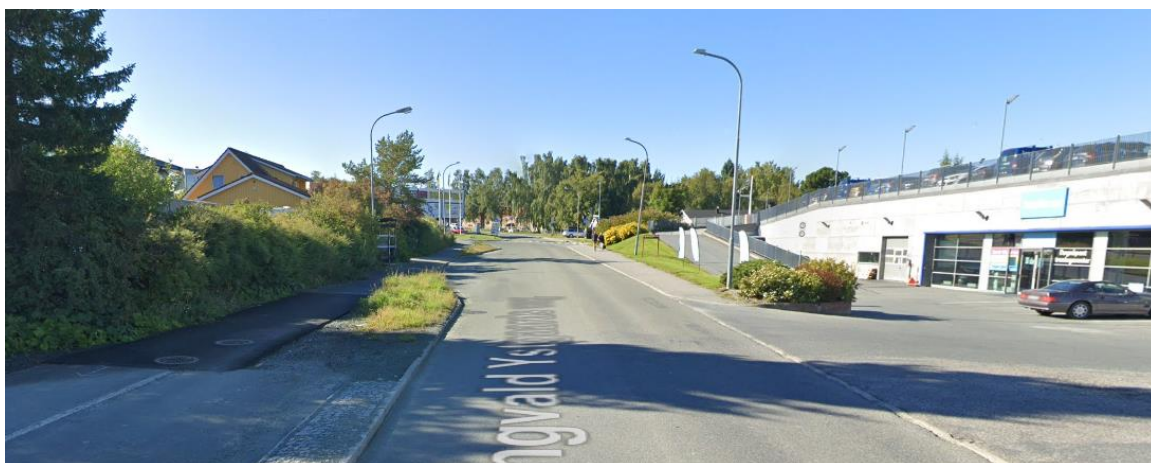
Figur 51: Ingvald Ystgaards veg sett mot Angelltrøa og Granåsvegen. Til venstre ses overgangen fra dagens relativt nybygde sykkelveg med fortau, til gang- og sykkelveg videre mot Angelltrøa.
