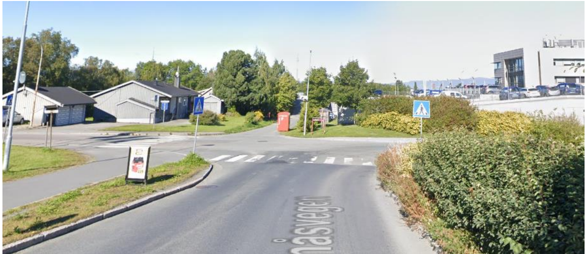
Figur 53: Bildet viser hvor dårlige siktforhold det er i krysset Granåsvegen x Ingvald Ystgaards veg. Til høyre i krysset ligger dagens gang – og sykkelveg i Ingvald Ystgaards veg.
