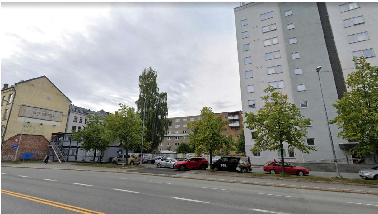
Figur 3 Situasjonsbilde Elgeseter gate 26
