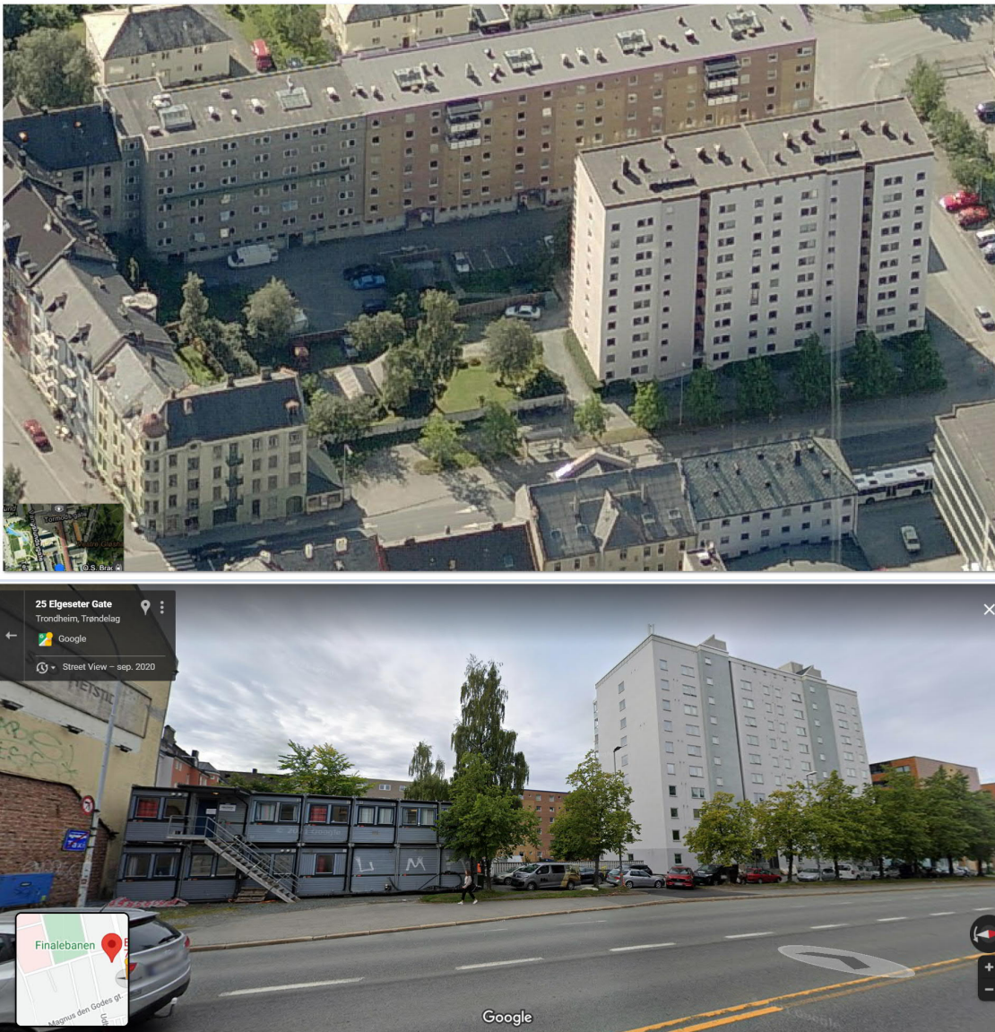
Figur 1 Dagens situasjon ved Elgeseter gate 26
