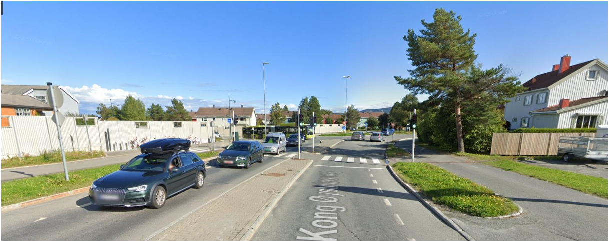
Figur 20: Kong Øysteins veg i dag, med tosidig gang- og sykkelveg pluss tosidig sykkelfelt. Signalregulert gangfelt og avkjørsel til bensinstasjon til høyre i bildet.
