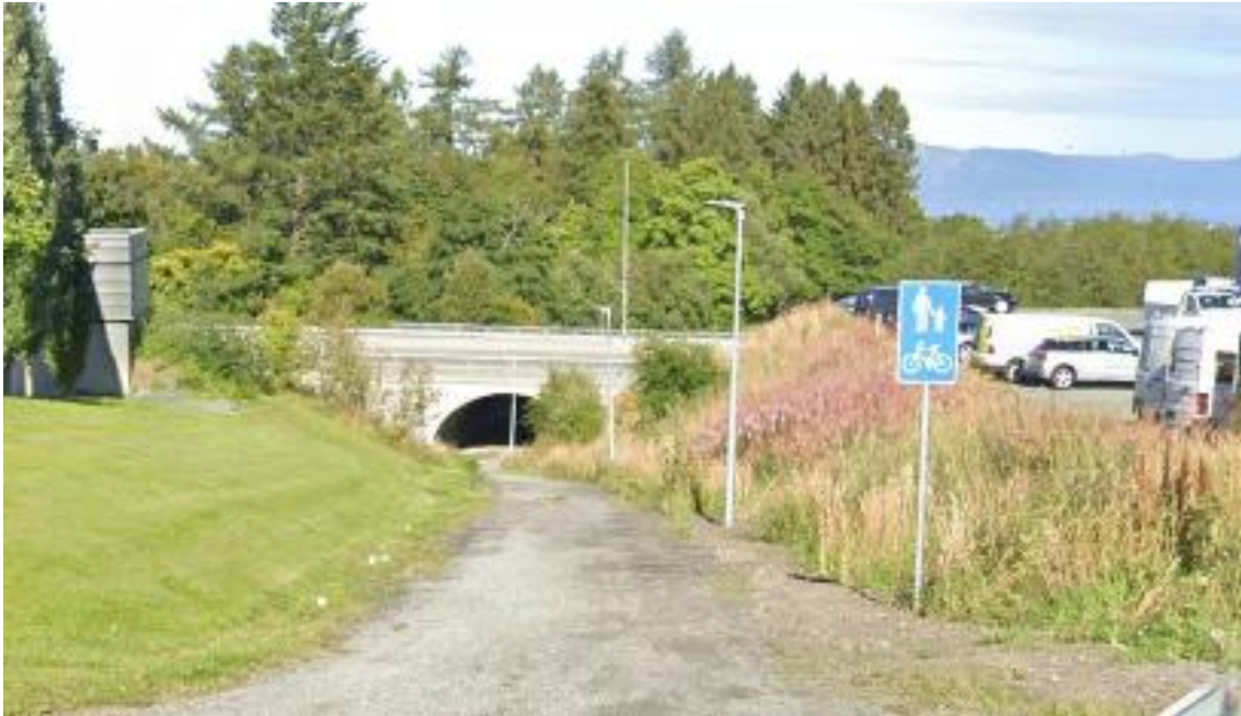
Figur 46: Dagens gang- og sykkelveg ned mot Reitgjerdet kulvert, sett fra Ingvald Ystgaards veg
