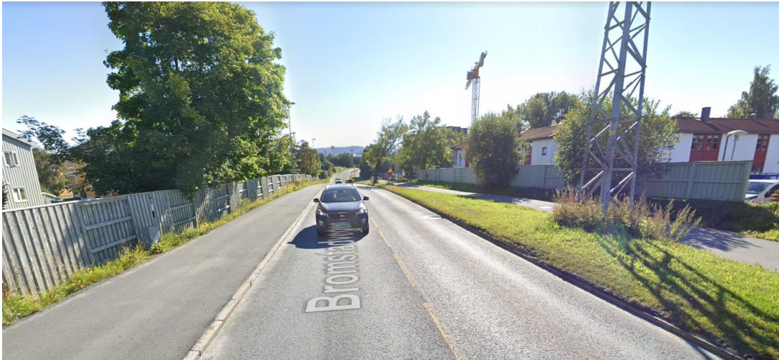
Figur 26: Bromstadvegen mot sør, Strindheim hageby til venstre i bildet. Støyskjerming på begge sider av vegen. Høgspenningmast på høyre side.
