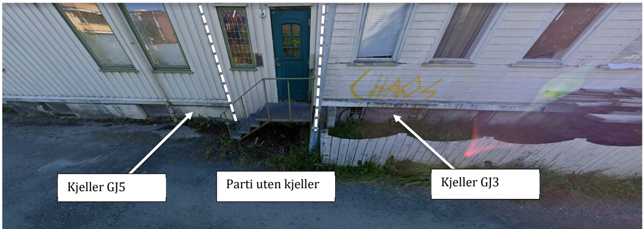
> Figur 2. Bilde fra nordsiden av Gisle Johnsons gate 3 og 5, fra Google Street view
