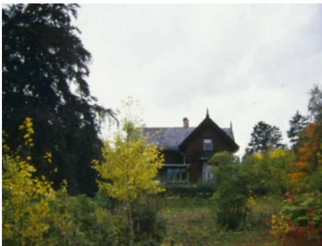
Hovedbygningen fra nord, 1984. Kilde: Byantikvarens arkiv
