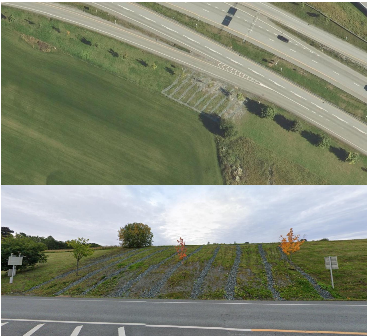
Figur 4: Pukkgrøfter i skråning mot E6 for overflatestabilisering. Flyfoto og stedsfoto fra år 2020.
