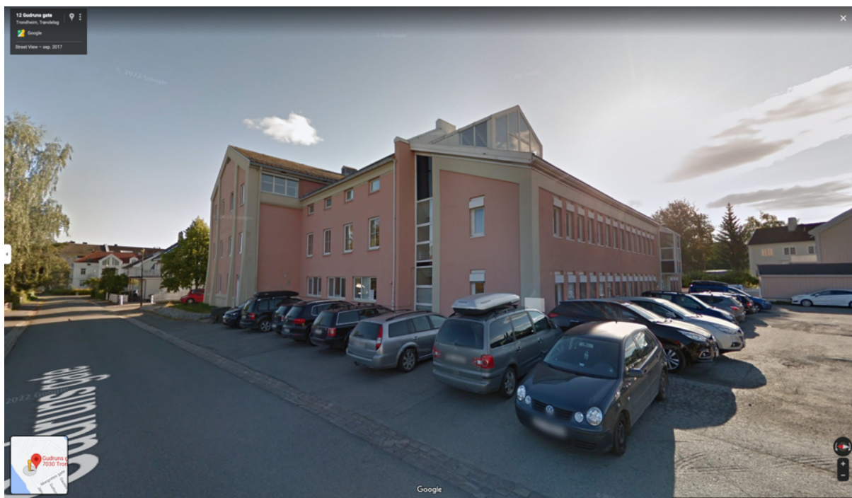
Eksisterende bygning sett fra Jørunds gate. Kilde: Google street view
