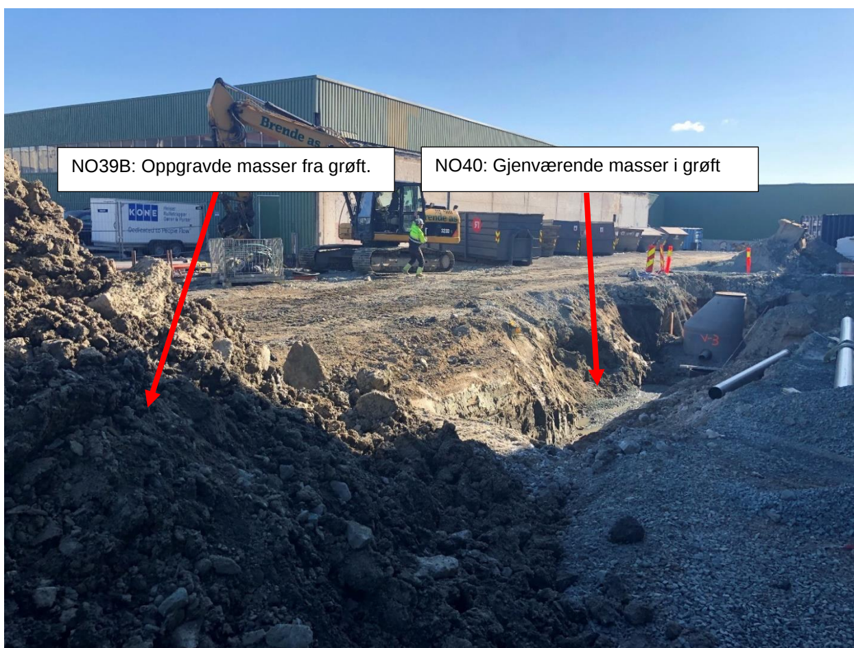
Figur 6: Prøvetaking av masser tilknyttet VA-trasé nord for hangar. Oversikt over hvor jordprøve NO39B og NO40 ble tatt ut.
