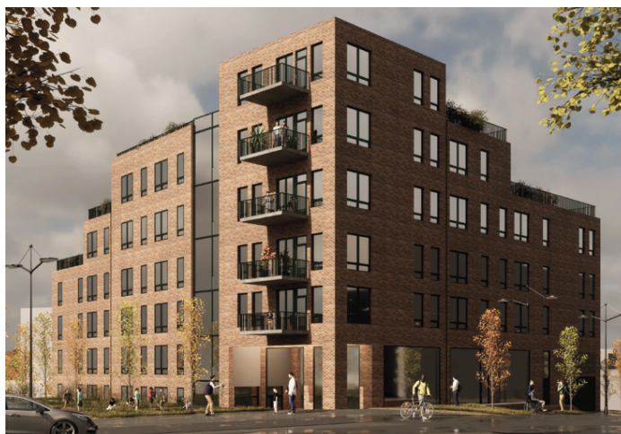
Fasade mot øst og nord (mot Håkon Magnussons gate)
