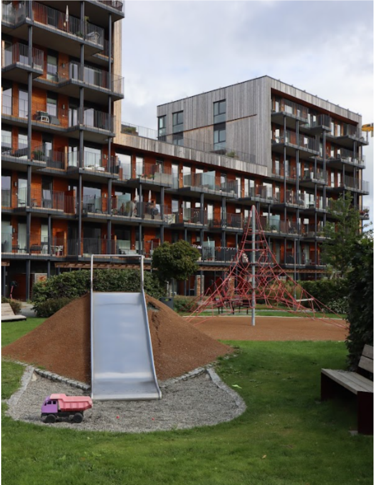
Eksempel fra Lilleby med god visuell kontakt mellom uteareal på bakken og felles takterrasse. Takterrassen er også plassert slik at den høyere bebyggelsen skjermer for vind og gir opplevd trygghet.
