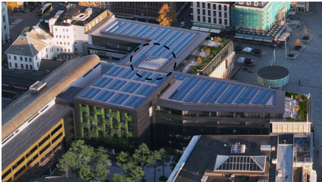
Bildet viser intensjonen med et lavt oppbygg for nytt overlys, markert med stiplet svart sirkel.
