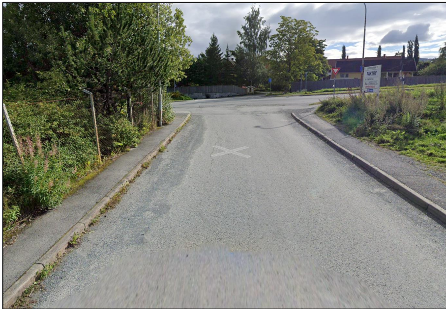
Figur 30 Adkomst til Leirfossvegen med dårlige siktforhold og smale fortau (kilde: google.com/maps )
