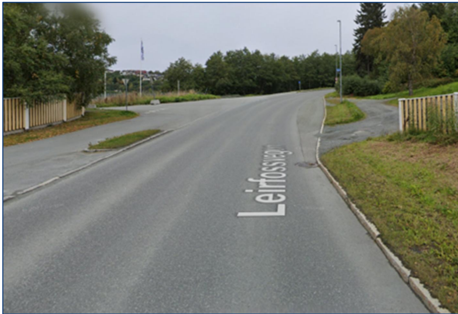
Figur 8 Holdeplass Leirøya i Leirfossvegen fra sør (kilde: google.com/maps )
