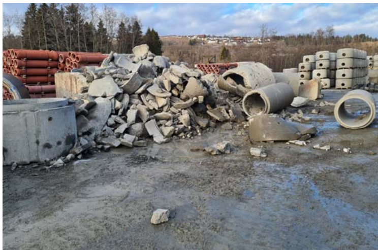
Figur 13: Lagring av delvis knust betong vest på eiendommen. Foto: Multiconsult.
