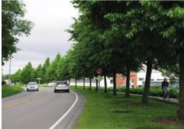
Figur 45 Trær langs vei som reduserer støy og støv og skjerner gående og syklende fra trafikken (Statens Vegvesen)
