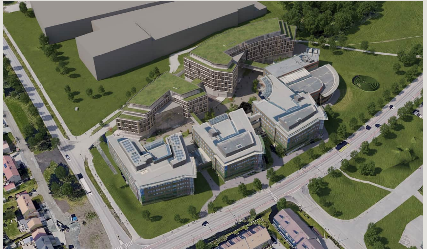
Oversiktsbilde fra øst - eksisterende situasjon
