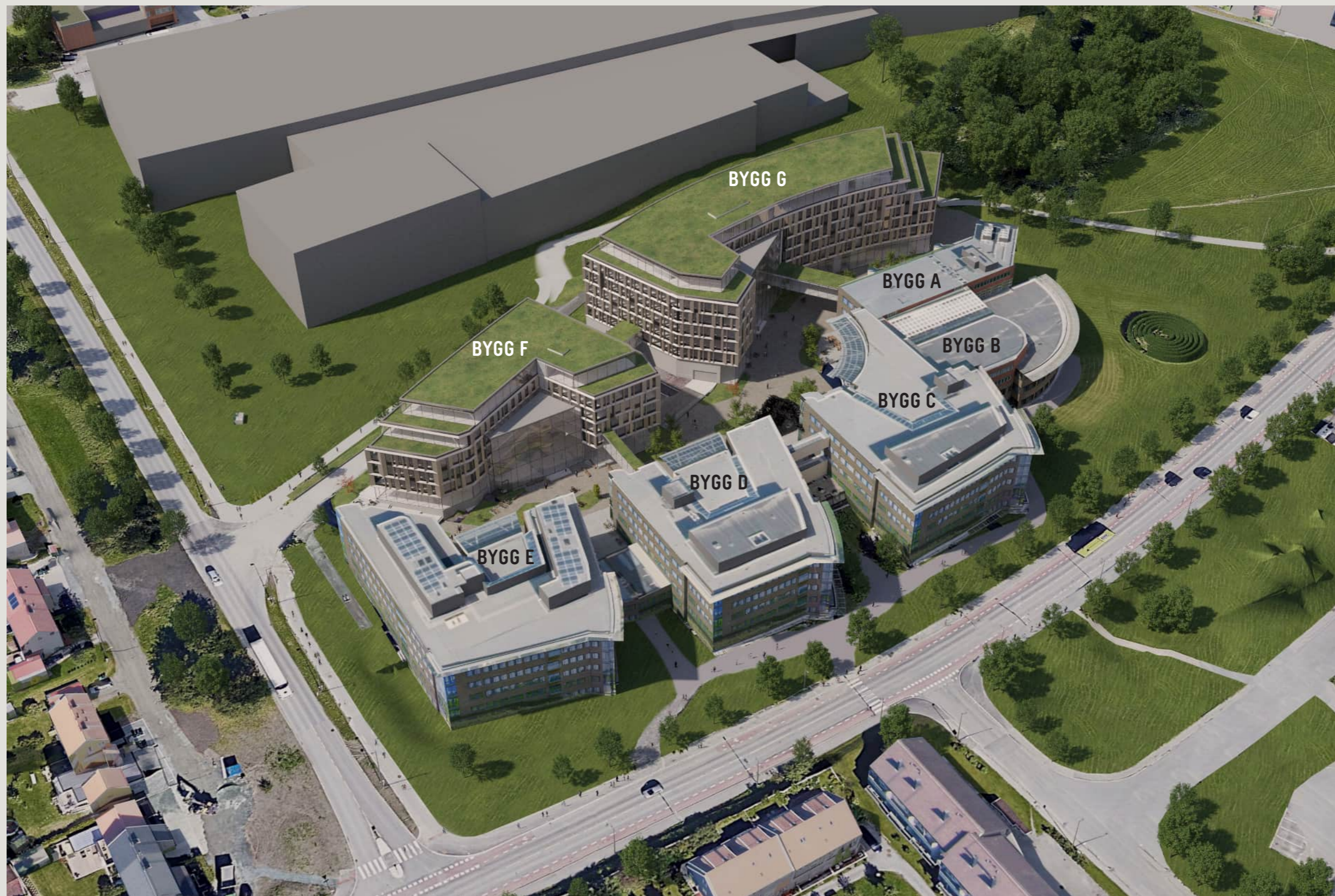
Oversiktsbilde fra øst - ny situasjon
