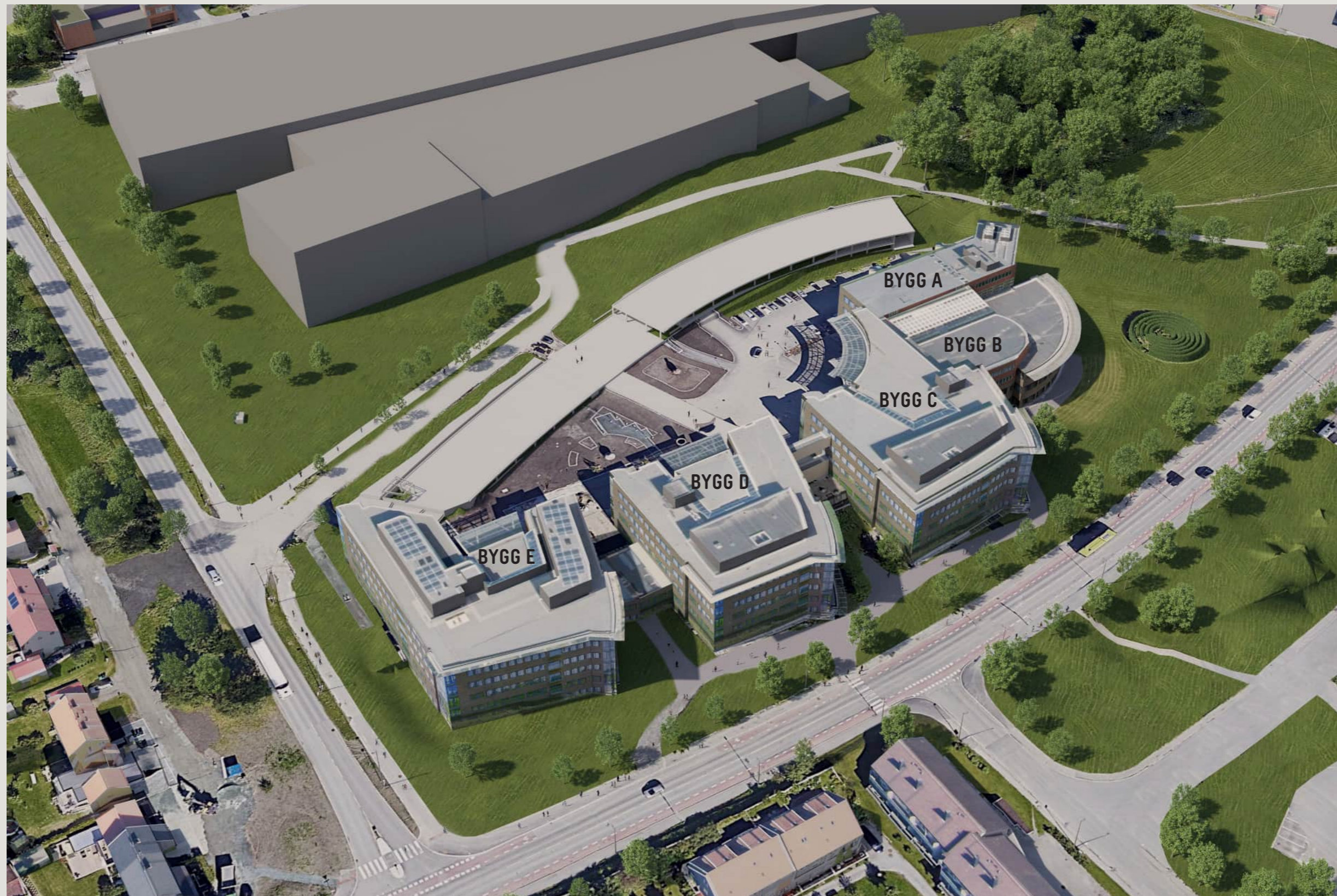
Oversiktsbilde fra øst - eksisterende situasjon
