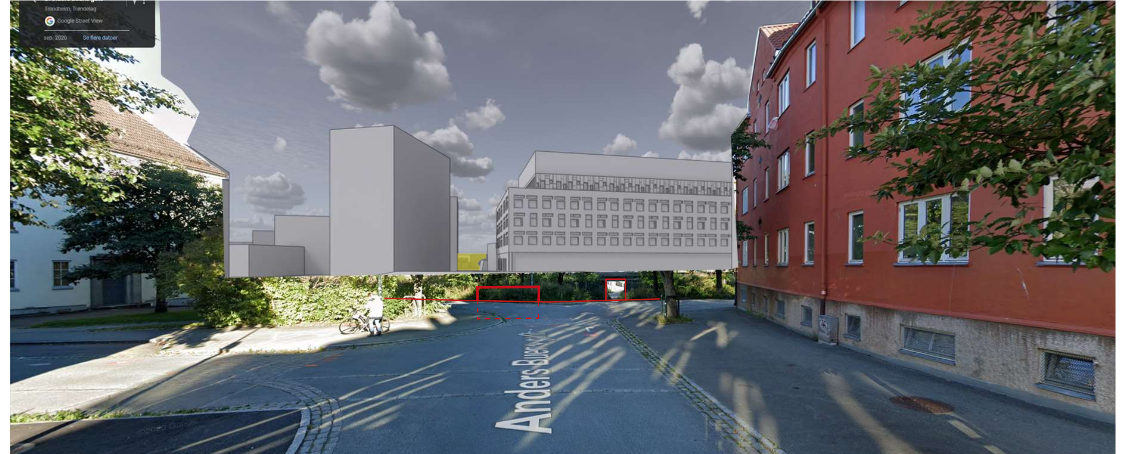
Foto fra Google maps med 3d modell Strandveien 43. Synliggjort ca. topp skinnegang
