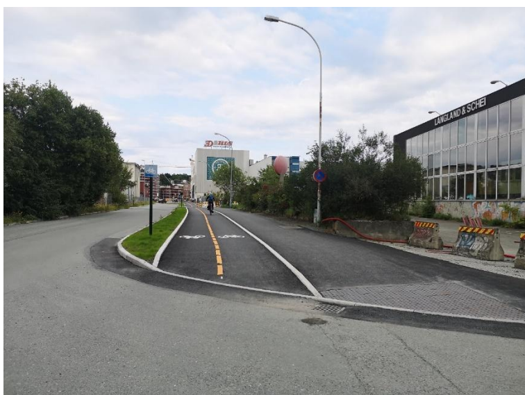
Figur 12 Sykkelveg med fortau, Strandveien (august 2020)
