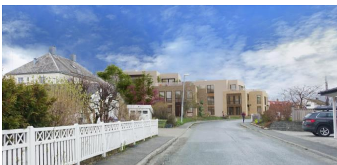
Figur 8 Sett fra Njardarvollen nord, bebyggelsen framstår i 2 etasjer med tilbaketrukket 3. etasje
