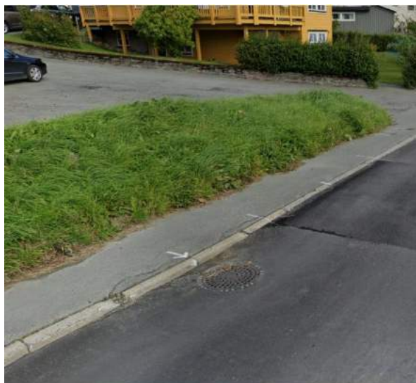
Figur 10: Sandfangskum langs eksisterende fortau i Sunnlandsskrenten. Bilde fra Google Street View.
