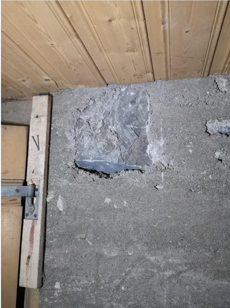
Figur 4: Store sparesteiner er brukt i bæreveggene.
