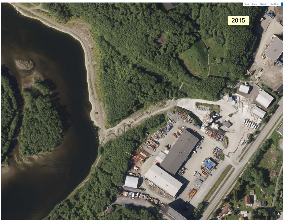
Figur 7.4 Yttersving ved Nidelva etter erosjonssikring av elv og bekk, flyfoto fra 2015
