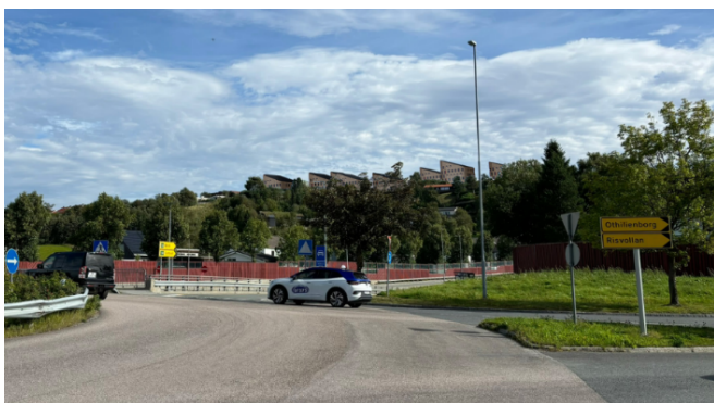
Fjernvirkning sett fra rundkjøring Utleirvegen/Omkjøringsvegen
