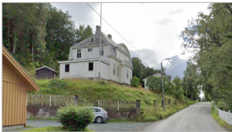
Dagens situasjon sett fra nord i Klæbuveien
