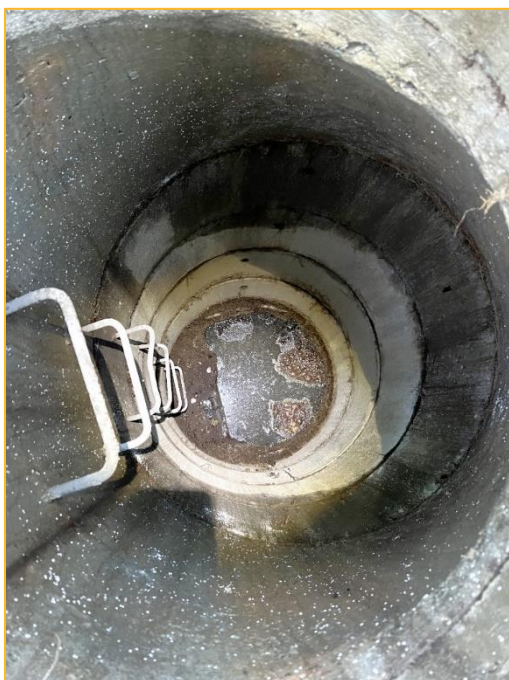
FIGUR 4 BILDE AV EKSISTERENDE KUM, SID UKJENT.
