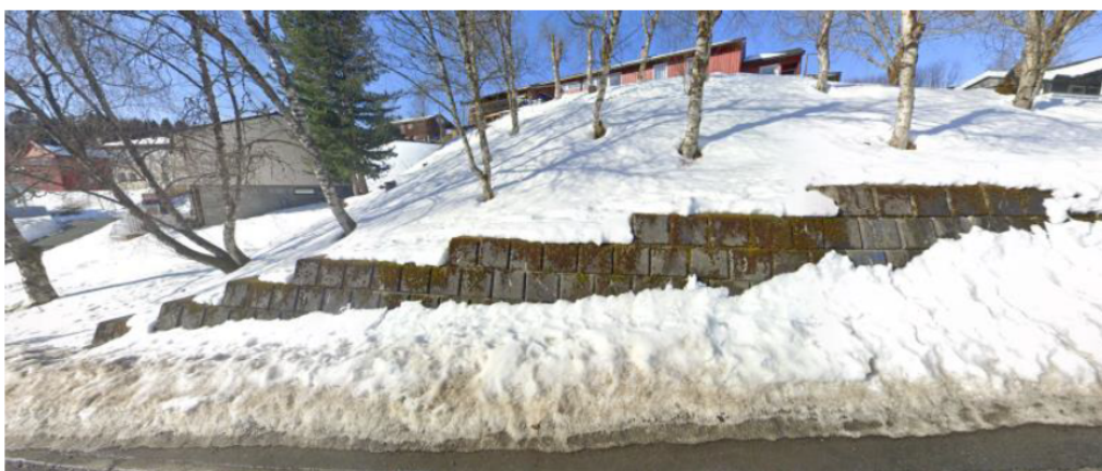
Støttemur langs vestsiden av vegen, ved Mikkelvegen 3B
