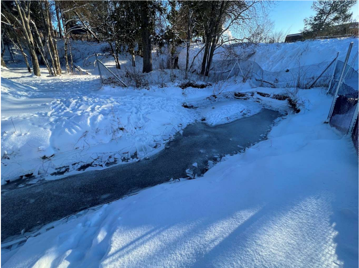
Figur 4-2: Bilde fra Multiconsult sin befaring. Sett mot inntaket til kulverten oppstrøms skoleområdet.
