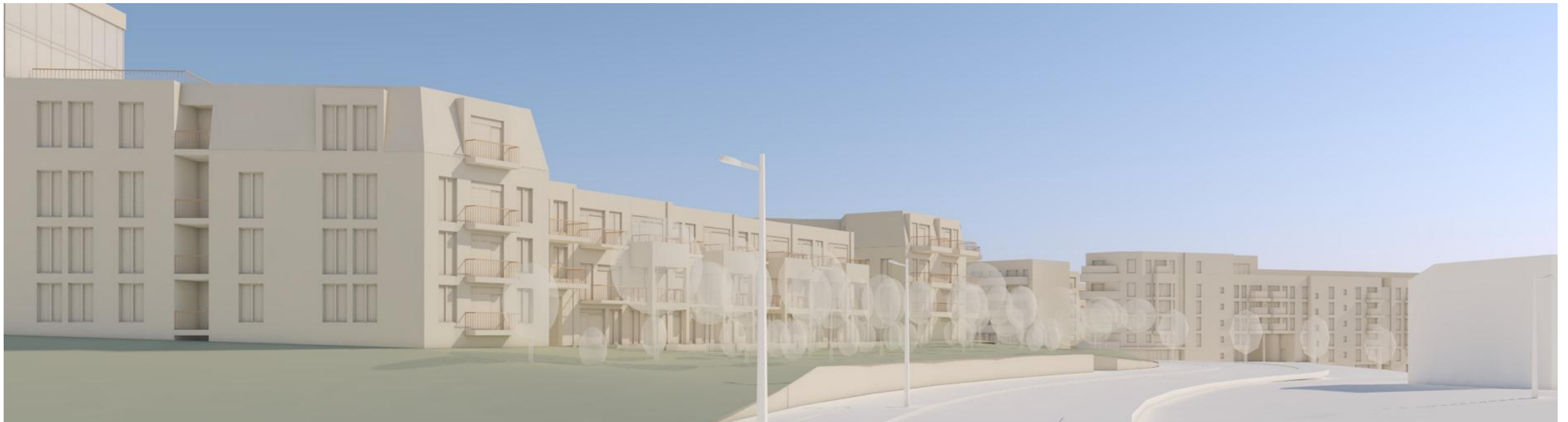
Sett fra øst i Hørløcks veg
