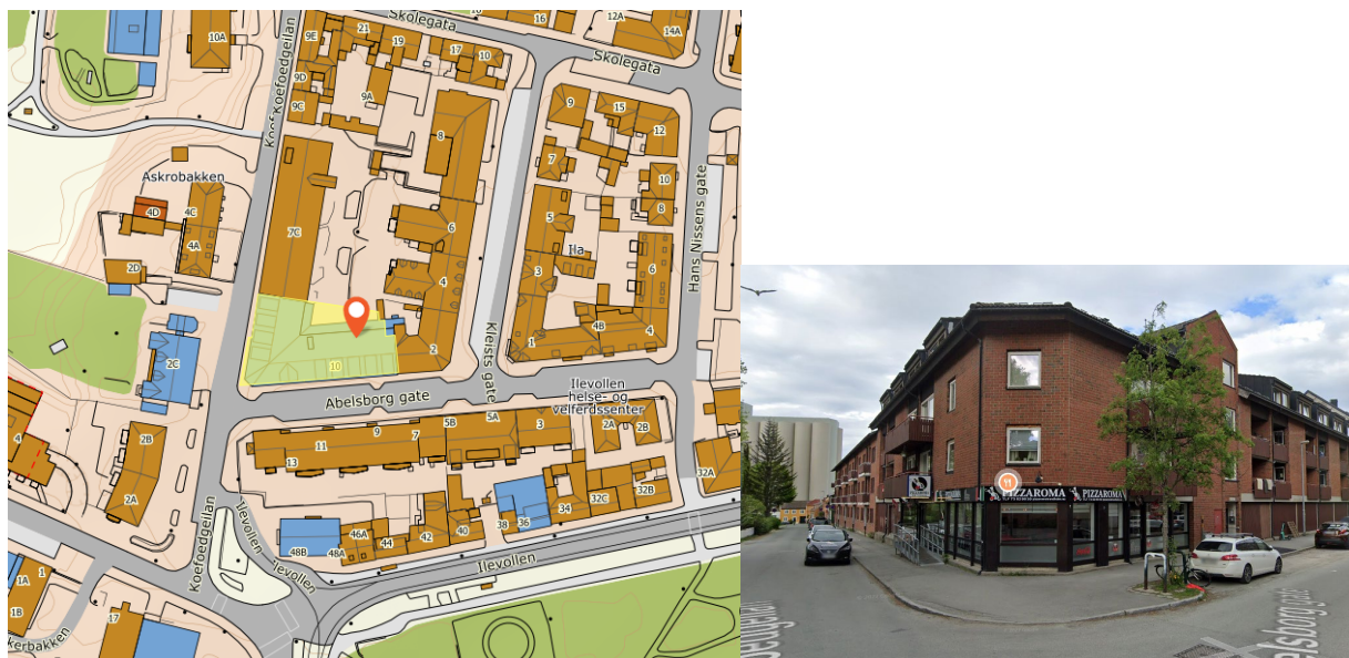
Figur 1 - Til venstre: Abelsborg gate 10 markert med rød markør. Hentet fra Norgeskart 2. april 2024. Til høyre: Eksisterende bebyggelse i Abelsborg gate 10 sett fra krysset Abelsborg gate og Koefoedgeilan. Hentet fra Google Streetview 2. april 2024.
