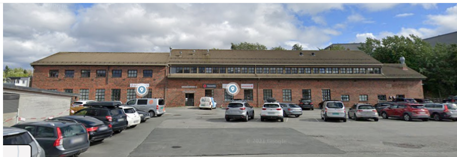
Bilde av Teglverksbygning som var del av Strinda Teglverk. Bebyggelsen brukes til kontorbebyggelse og foreslås for riving.
