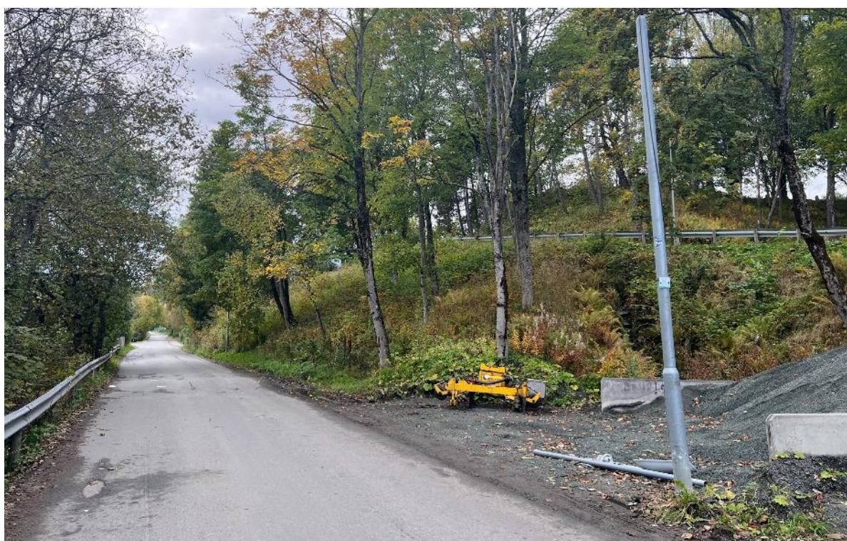
Figur 9: Bilde av Magasinvegen. Sandlager vises til høyre i bilde.
