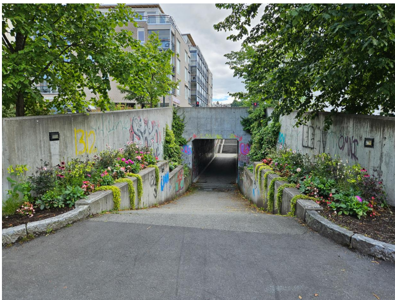
Figur 2 Undergang under Stadsingeniør Dahls gate lengst sør i Gyldenløves gate
