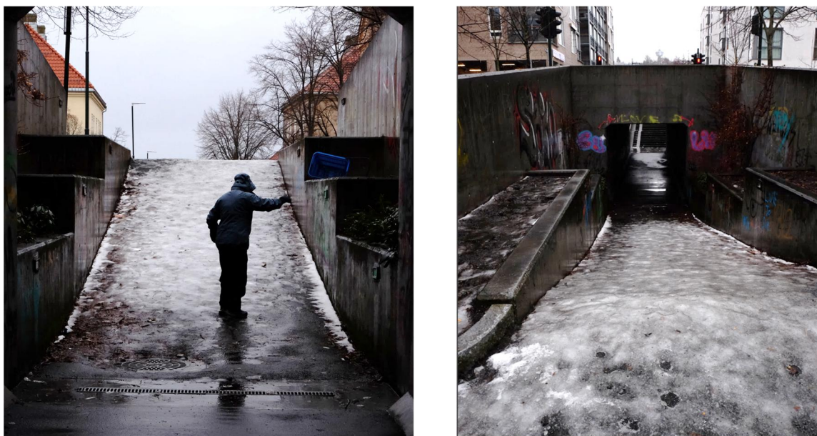
Figur 3 Undergang Stadsingeniør Dahls gate mot og fra Gyldenløves gate (foto Rambøll)
