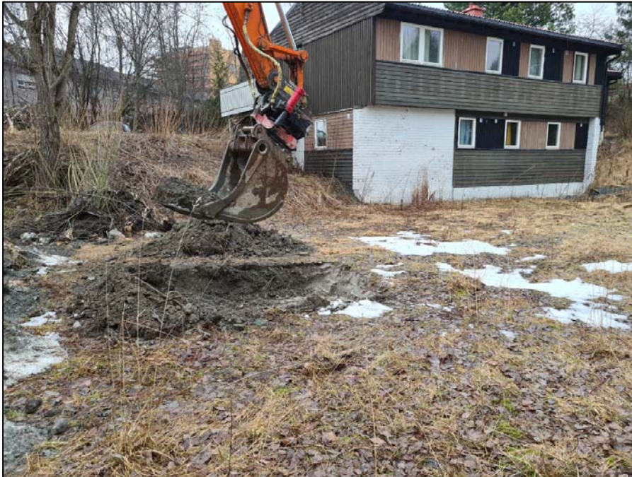
Figur 22: Bolig i Klæbuveien 217 sett fra øst. Foto: Multiconsult, 24. mars 2022.
