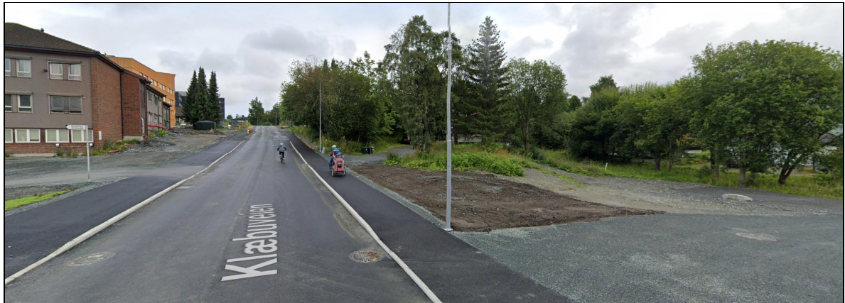
Figur 9 Ved Klæbuveien 217 retning nord (google.com/maps, 2023)
