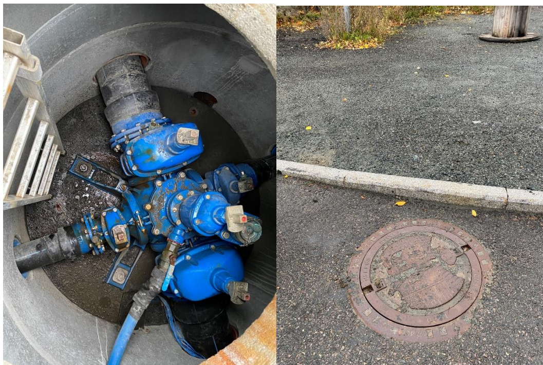
Figur 4: Kum 384955. Bilder fra befaring 15. oktober.
