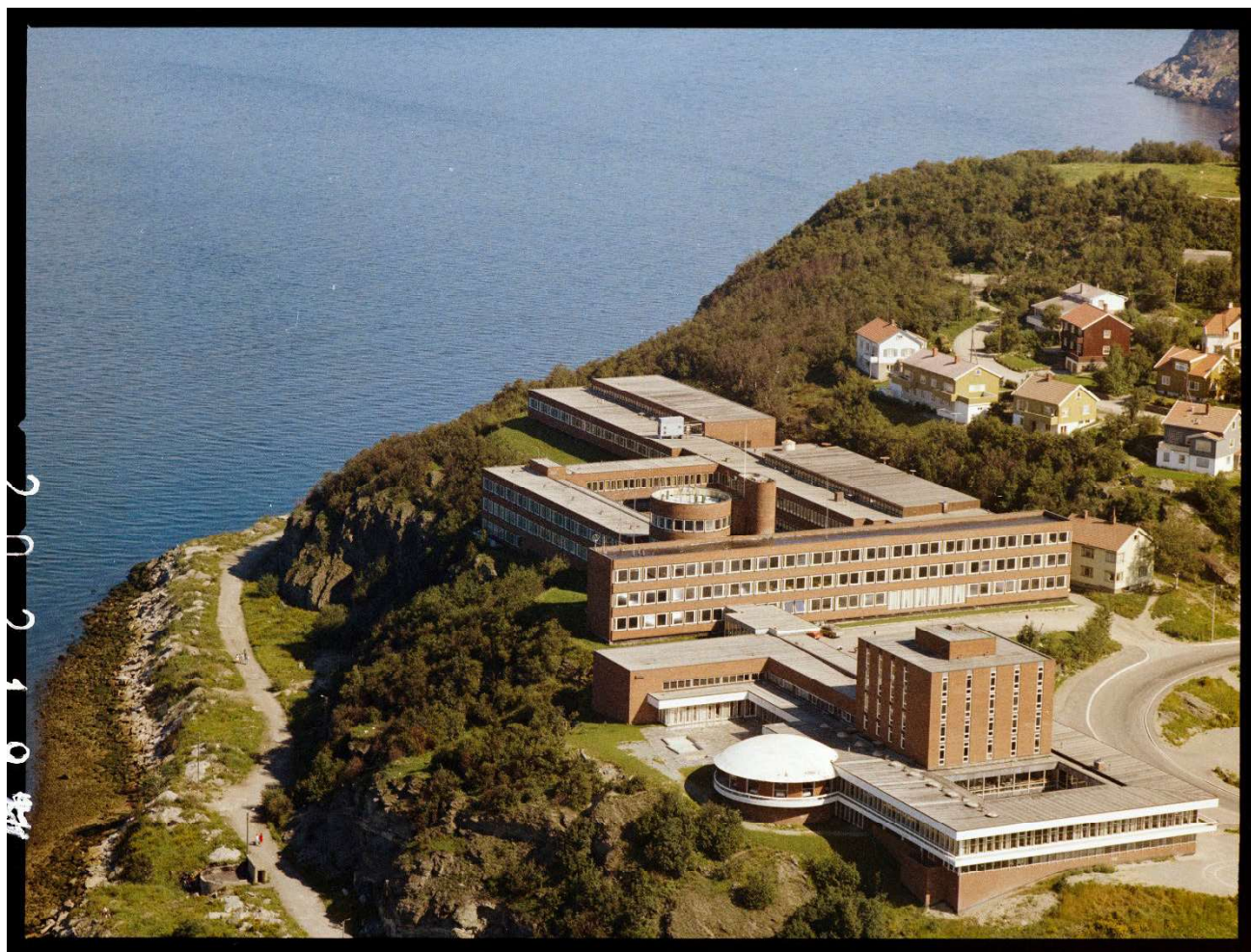
Fig 9. Anlegget før bygg F ble oppført. Ukjent årstall, men mellom 1964 og 1977. Foto: Fjellanger, Widerøe
