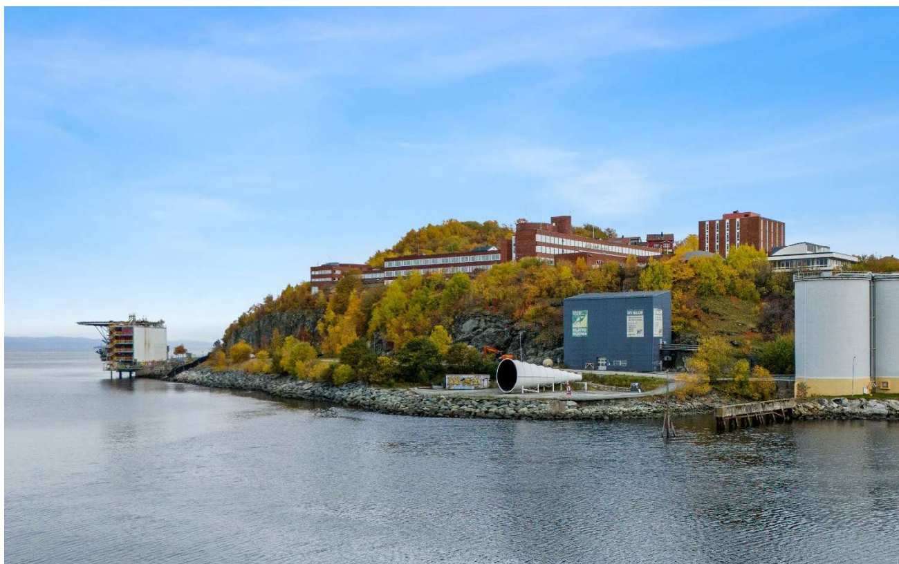
Fig. 12. Dagens situasjon på Ladehammeren, fotografert høsten 2024. I sommerhalvåret dekker vegetasjonen noe av bebyggelsen, spesielt anleggets møte med bakken.
