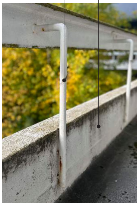
Rekkverk og balustre i metall, males hvit
