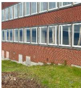
eksponert ringmur av betong i flukt med tegl som avtrappes med terreng på vestsiden av bygg C
