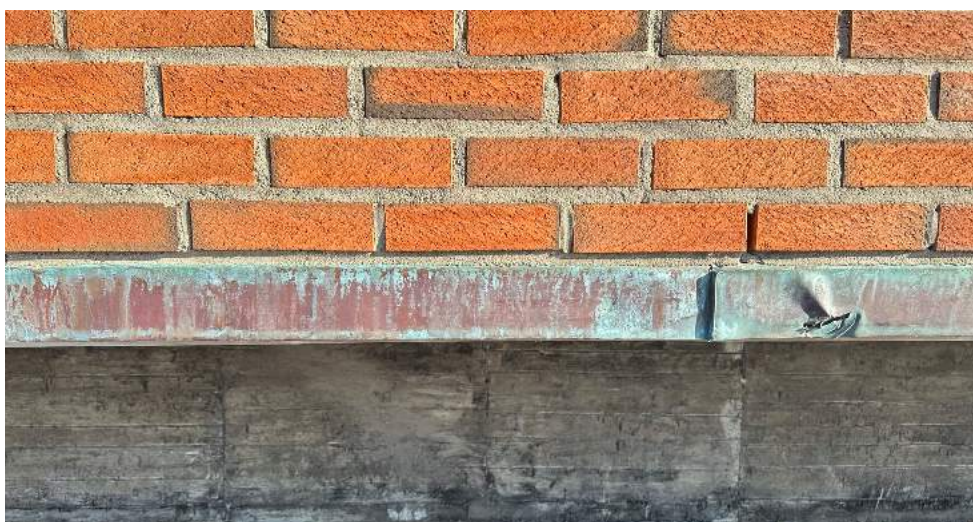
Kopperbeslag med stående fals i underkant av teglforblendingen med samme høyde som tegl med mørtel (bygg E)
