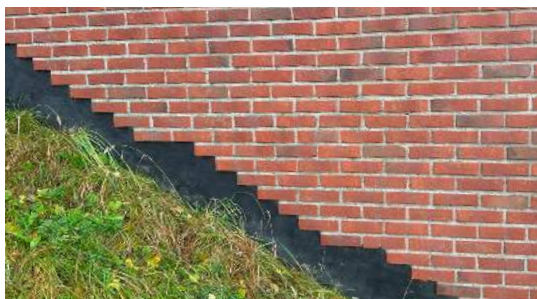
ringmur av betong i flukt med tegl og påført en sort membran (nordsiden av bygg C)
