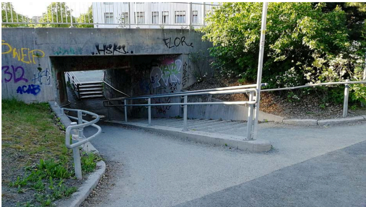
Figur 37: Eksisterende undergang under jernbanen ved Lilleby stasjon med trapp og bratt rampe med håndløper.
