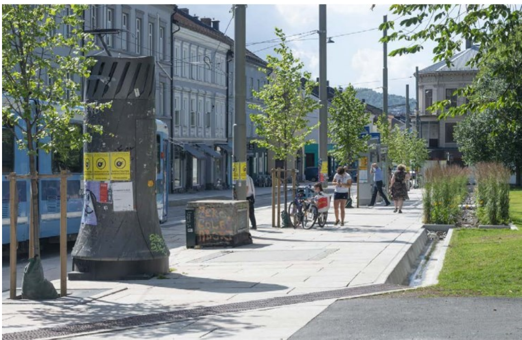
Bilde 1: Eksempel på åpen grøft for føring av overvann fra veg til regnbed. (Rambøll, Henning Larsen, Oslo kommune, 2023)
